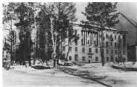
Строительство гостиницы "Центральная".
