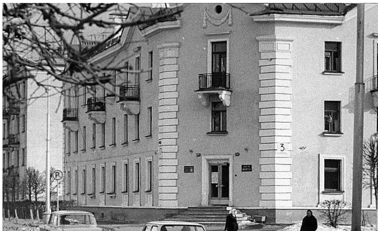
Дом на углу улиц Ленина и Советская построен заключенными в июне 1954г. На первом этаже в 1954 г. была открыта музыкальная школа.
