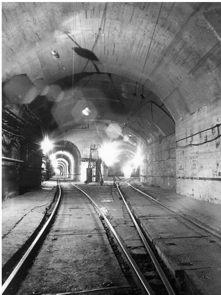
Железнодорожный тоннель (в эксплуатации)
