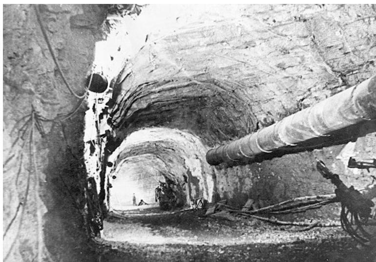
Прходка тоннеля. 1952г.
